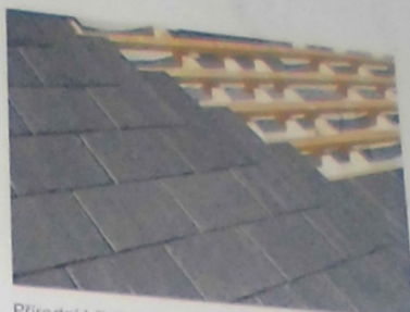
Přírodní břidlice v moderním formátu při pokládce na střechu novostavby rodinného domu
