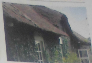
Došková střecha po pár letech proroste mechem, čímž se zvýší její izolační schopnosti i trvanlivost
